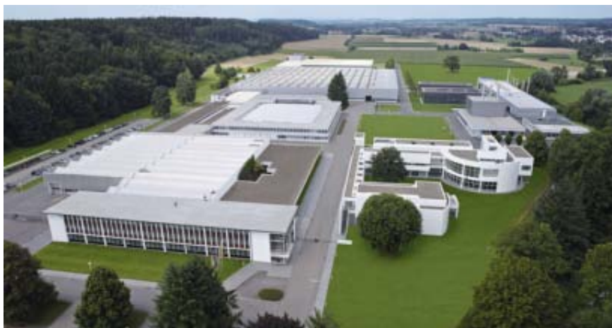
Überblick: das Werk Schwendi mit den Verwaltungsgebäuden vorn links, gegenüber das Weishaupt Forum, rechts dahinter die Heizzentrale mit Forschung und Entwicklung, im Zentrum die Fertigung mit den Montage- und Lagerhallen.
